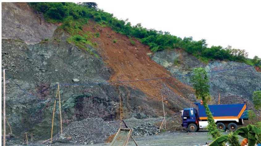
Figura 1 / El sitio de un deslizamiento de tierras que tuvo lugar en la cantera en 2016, durante un tifón. Cuando las lluvias son intensas, se genera una pequeña cascada en esta área. Fuente: Pryor Placino.
